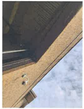
A2 Door "A" Exterior
