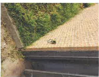
A3 Door "A" Exterior
