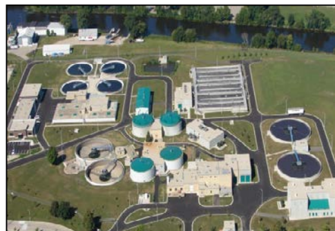
Fond du Lac WWTP.
